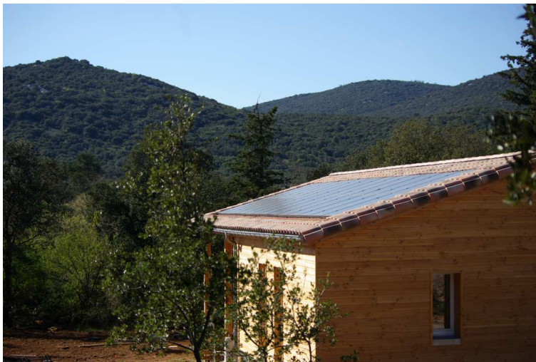
Installation de Viol le Fort
